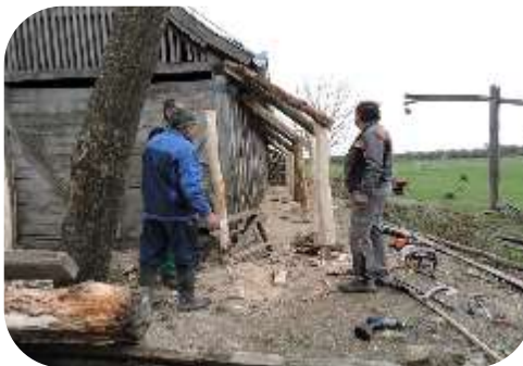
Radovi na infrastrukturi
